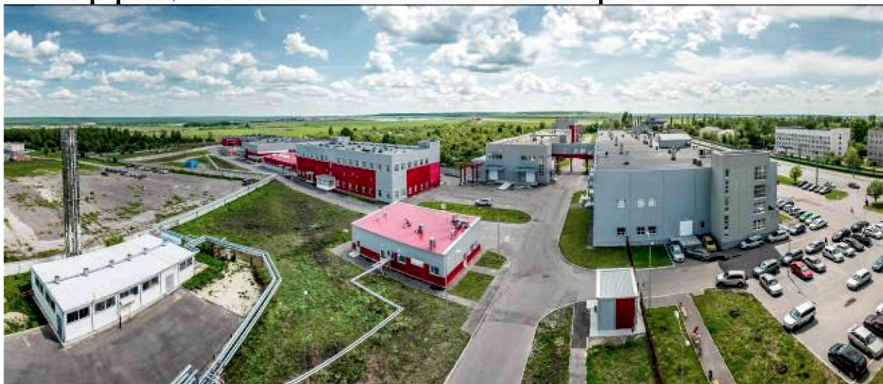
Рис. 3. Объекты 2 и 3 этапов технопарка
