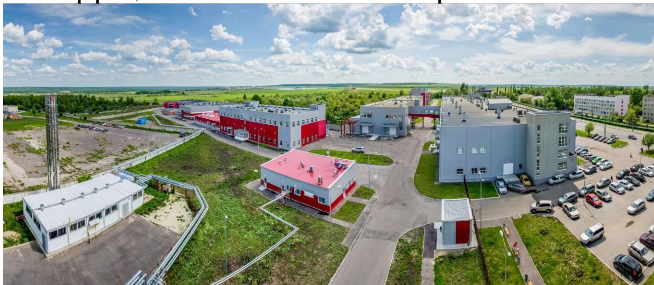
Рис. 4. Объекты 2 и 3 этапов технопарка
